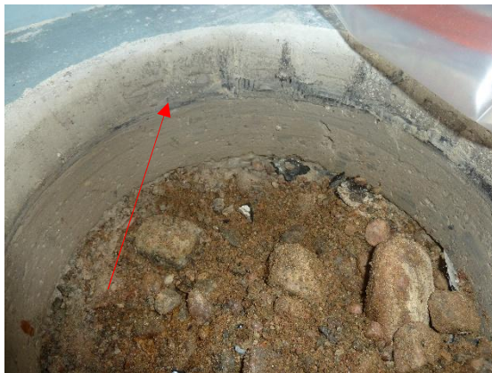
Kuva 12. Alapohjarakenteessa bitumisively on usein alemman betonilaatan pinnassa (kuvassa näyte 20). Bitumin päällä oli paikoin sementtipuukuitulevykerros.
