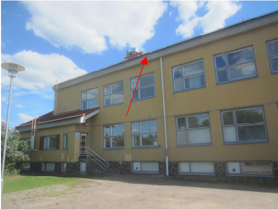
Sadevesikourun valkoisesta maalista otettu näyte ei sisältänyt asbestia.
