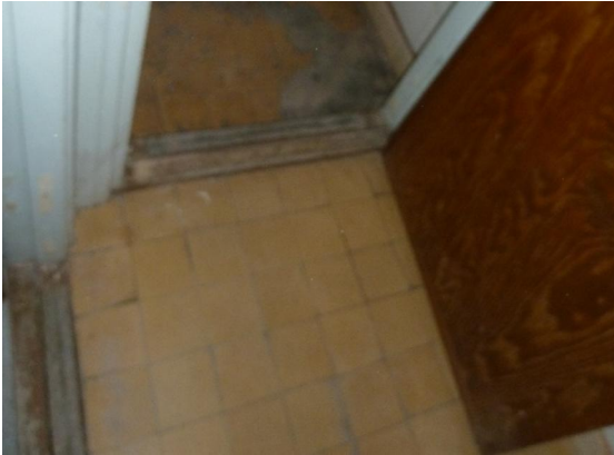
WC lattian laatoitus ei sisällä asbestia.
